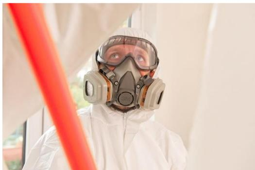
und auch eine mögliche Mietminderung – zu vermeiden, beauftragte er den zuständigen ISOTEC-Fachbetrieb mit einer professionellen Schimmelsanierung in den befallenen Räumen, Präventionsmassnahmen inklusive. Zunächst wurden von den mit Schutzanzügen, Handschuhen und Atemmasken ausgestatteten Profis die Zimmer, in denen jeweils gearbeitet wurde, staub- und luftdicht abgeschottet. „So verbleiben sämtliche Allergene im abgeschotteten Arbeitsbereich und
