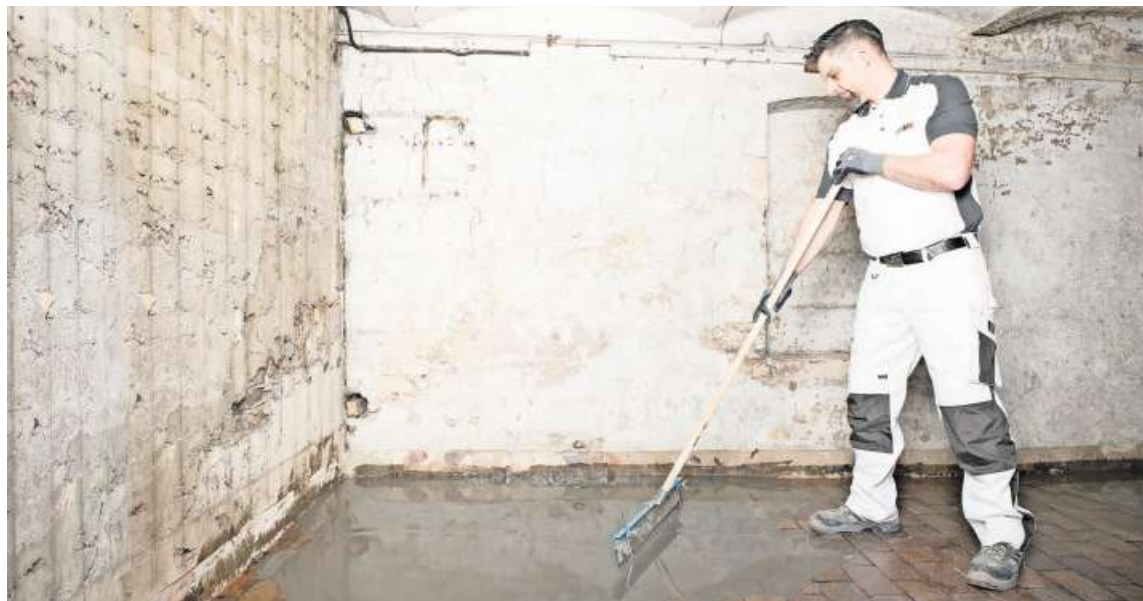
Feuchte Kellerböden können mit einem dreistufigen Beschichtungssystem nachträglich abgedichtet werden. Bild: zvg
